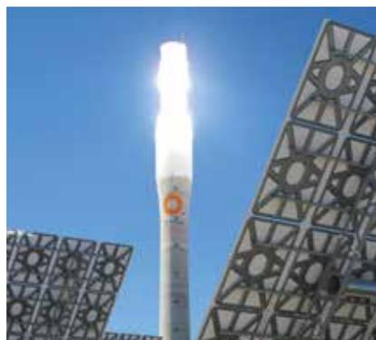
Ежегодно в эксплуатацию вводятся все более производительные гелиотермические электростанции. Для обеспечения мощности до 100 мегаватт и более используются несколько тысяч точно ориентированных зеркал, постоянно перемещающихся вслед за солнцем. Поскольку электростанции этого типа устанавливаются прежде всего в пустынях, используемые датчики должны не только точно работать, но и выдерживать суровые условия окружающей среды.
